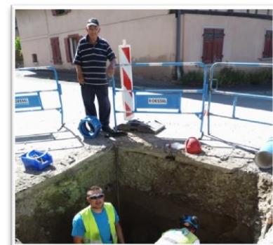
Germain Ricard: visite de chantier
