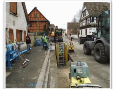
Travaux, rue Principale
