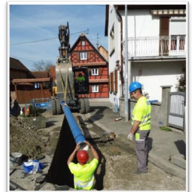
Mise en place des canalisations
