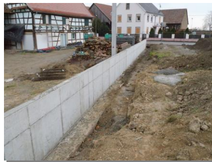
Les différentes étapes : (1) Terrassement & fondation ; (2) coulage d'un mur béton ; (3) réalisation de 2 allées pavées.
