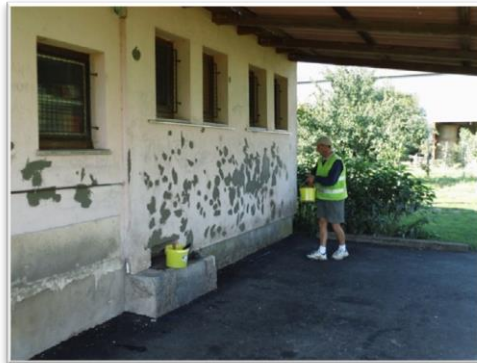
Réhabilitation du mur nord du Club-House
