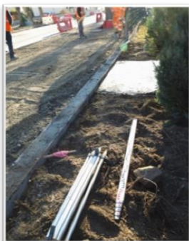
Mur de réalignment
