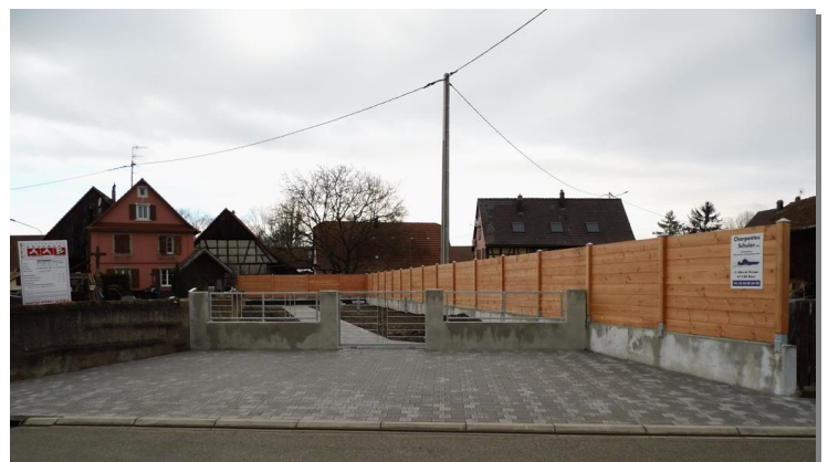
Vue sur l'extension du cimetière
