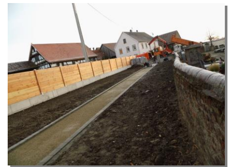
Les différentes étapes : (1) Terrassement & fondation ; (2) coulage d'un mur béton ; (3) réalisation de 2 allées pavées.
