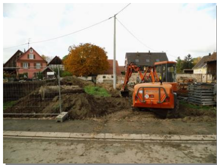
Les différentes étapes : (1) Terrassement & fondation ; (2) coulage d'un mur béton ; (3) réalisation de 2 allées pavées.
